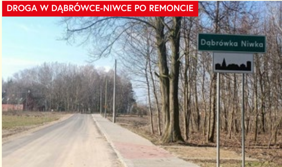
DROGA W DĄBRÓWCE-NIWCE PO REMONCIE
